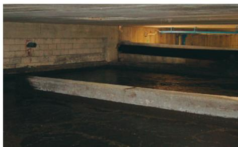
Sono degni di particolare nota i depuratori costruiti completamente al chiuso per evitare la diffusione di odori sgradevoli nelle abitazioni site in prossimità: essi dovrebbero essere smantellati a causa delle condizioni di lavoro molto disagiati, sia in estate sia in inverno, in quanto a microclima e salubrità dell'aria. Qualora ciò non fosse possibile, è necessaria una maggiore automazione per evitare o limitare al minimo gli interventi manuali.
